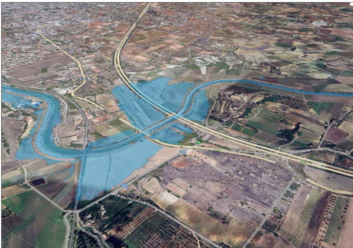
Fig. 28. Vista a volo d'uccello - Aree Suscettibili di Allagamento – attraversamenti E90 e SS115 - Tr = 50 anni
